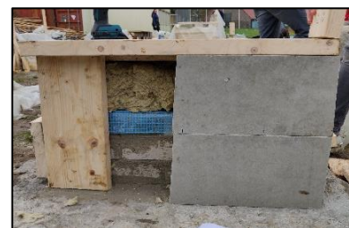
figuur 4.3.3 Halve isolatie platen en ondersteuning
