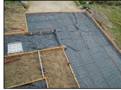
Figuur 2.4.8 Houten bekisting
