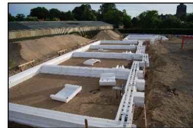
Figuur 2.1.2 Piepschuim bekisting
