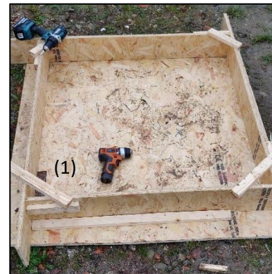
figuur 4.1.1 Bekisting
