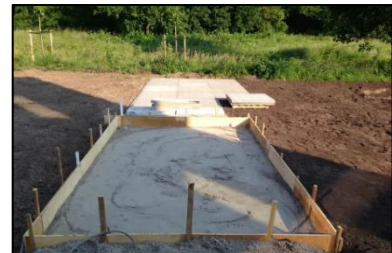
Figuur 2.1.6 Bekisting met betonplaat
