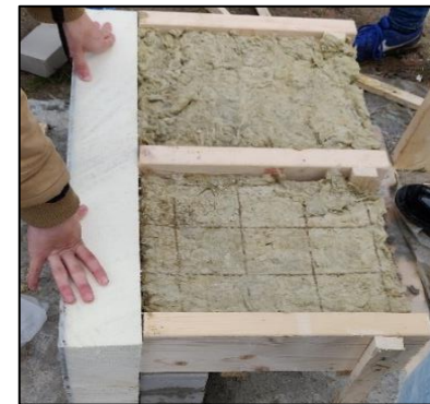
figuur 4.2.5 Vloerbalken met isolatie
