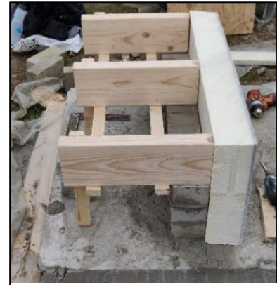
figuur 4.2.4 Vloerbalken en isolatie op ondergronds metselwerk
