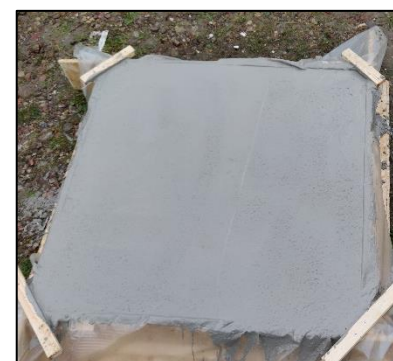
figuur 4.1.3 Bekisting met nat beton
