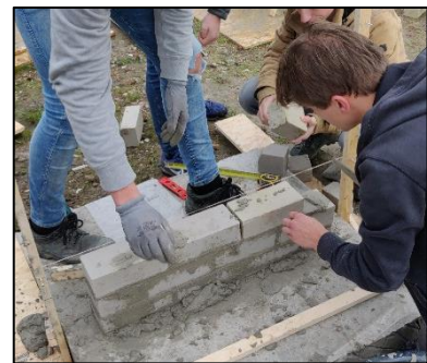
figuur 4.2.2 Ondergronds metselwerk
