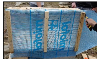
figuur 4.3.6 Damp-open folie koude kant
