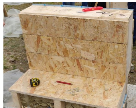
Figuur 4.4.1 OSB-afwerking i.p.v. gipsplaten
