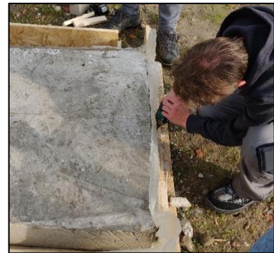
figuur 4.2.1 Verwijderen bekisting
