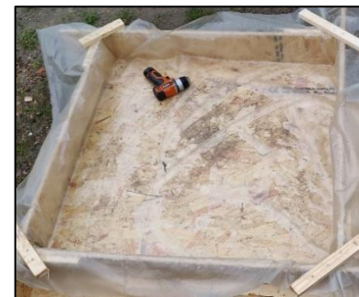
figuur 4.1.2 Bekisting met plastic
