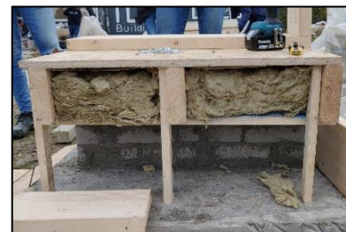
figuur 4.3.2 Remmende folie warme kant, vloer en onderste ligger
