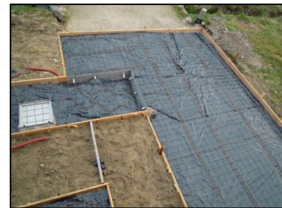
Figuur 2.1.1 Houten bekisting
