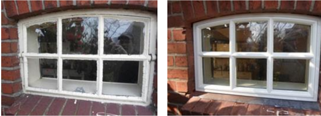
FIGUUR 36 - VOORBEELD VERVANGEND KOZIJN
