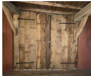
Dubbele staldeur oostzijde
