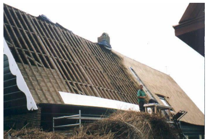
FIGUUR 30 - RIETEN DAK ISOLATIE
