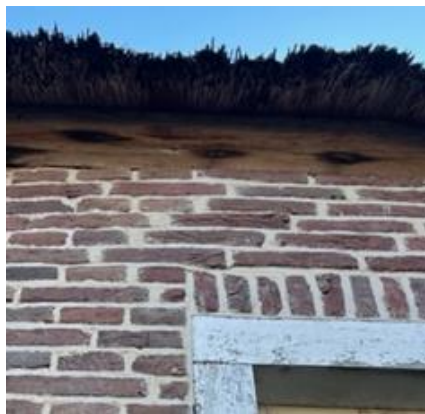
FIGUUR 16 HALFSTEENSVERBAND
