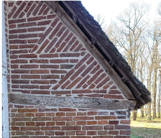
FIGUUR 14 METSELWERK HALFSTEENSVERBAND
