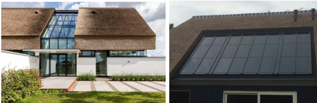
FIGUUR 37 - VOORBEELD VAN EEN LICHTSTRAAT (FENTROPAL.NL, SD)
