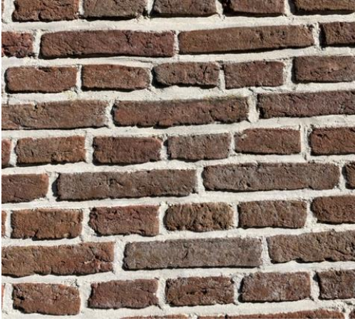
FIGUUR 13 METSELWERK GEVEL BOERDERIJ
