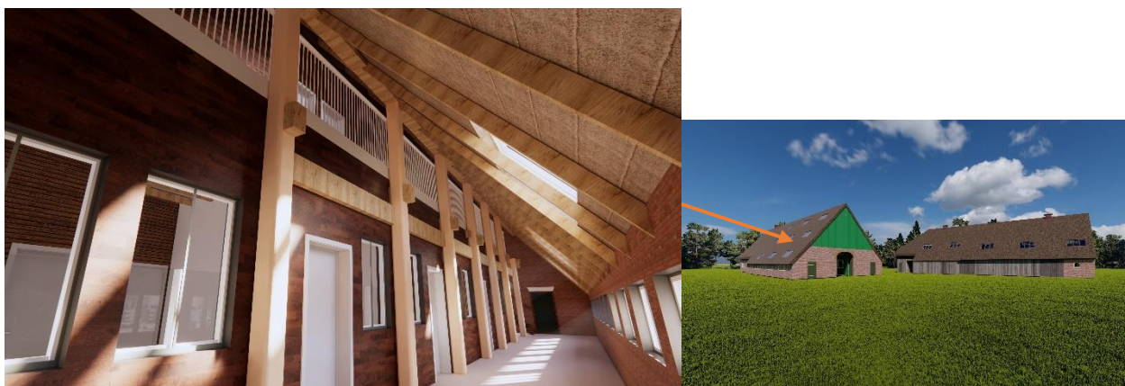
FIGUUR 42 - HOUTEN CONSTRUCTIE TEN PLAATSE VAN DE VIDE
