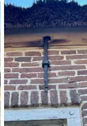
FIGUUR 44 - MUURANKER
