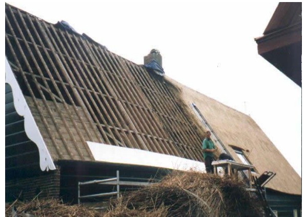
FIGUUR 16 - VOORBEELD DAKOPBOUW RIETEN DAK
