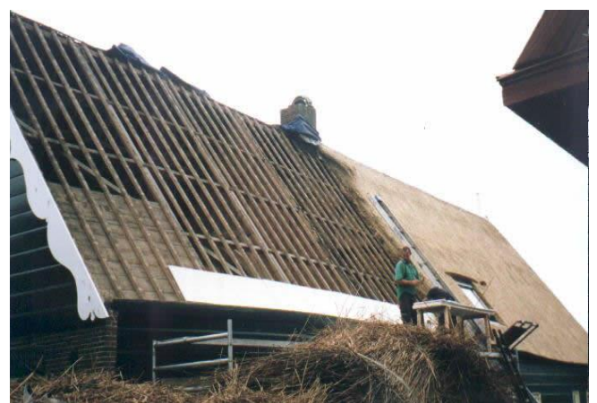
FIGUUR 30 - RIETEN DAK ISOLATIE
