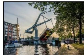
Figuur 21 Aan elkaar bevestigde balanspriemen met contragewicht achter
