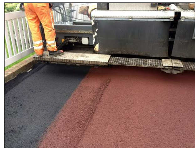
Figuur 5 Asfalt; fietspad en rijbanen
