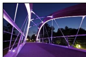
Figuur 23 Licht gekleurd in brug verwerkt
