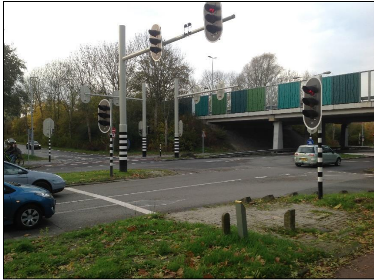
Figuur 1 Entree Zernikecomplex = viaduct
