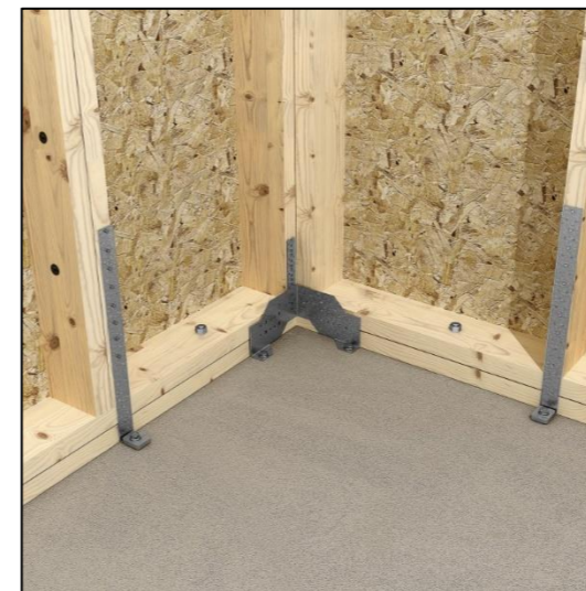
Figuur 6 Ankers die HSB constructie vastzetten
