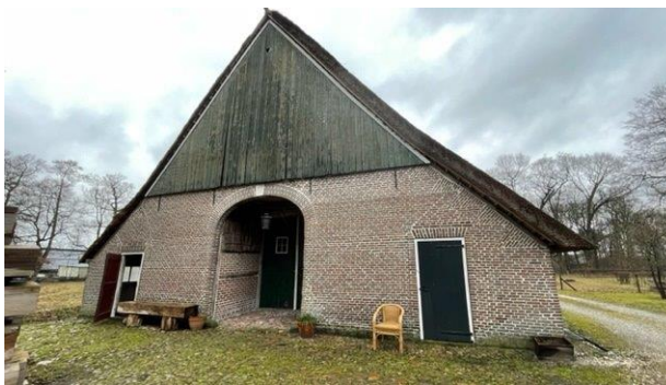
FIGUUR 39 – HUIDIGE VOORGEVEL ENGELENWEIJ
