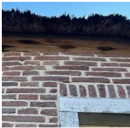
FIGUUR 16 HALFSTEENSVERBAND
