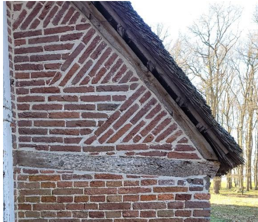
FIGUUR 14 METSELWERK HALFSTEENSVERBAND
