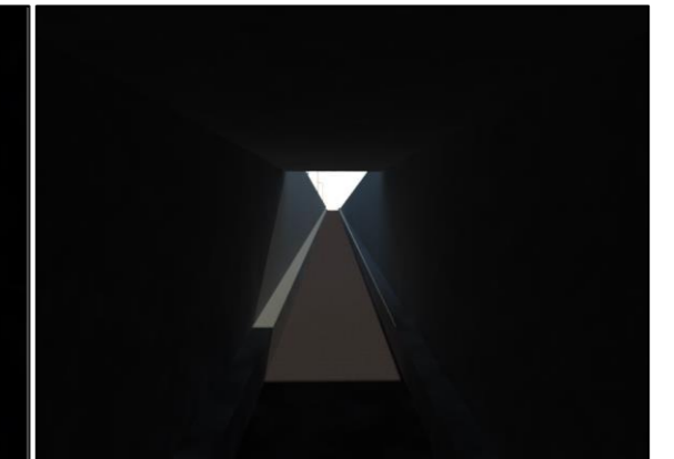
Figuur 7.1.3.8 Uitgang tunnel Bedumerweg
