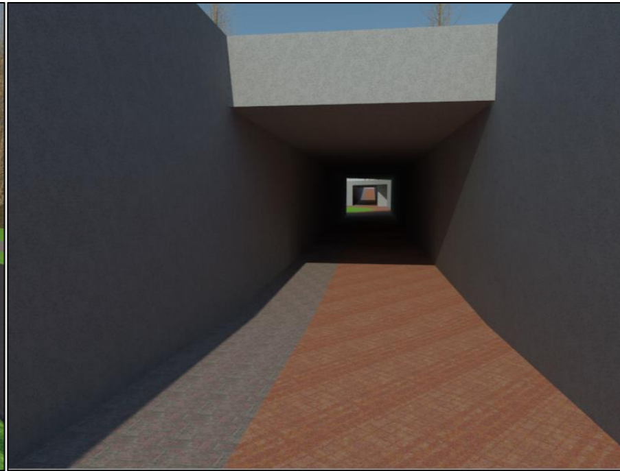
Figuur 7.1.3.10 Fietstunnel Bedumerweg
